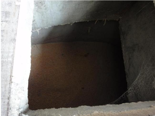
圖 2-10、圓筒倉上方開口周圍與玉米堆上層之玉米碎屑易吸取空氣中水份而致發霉。
