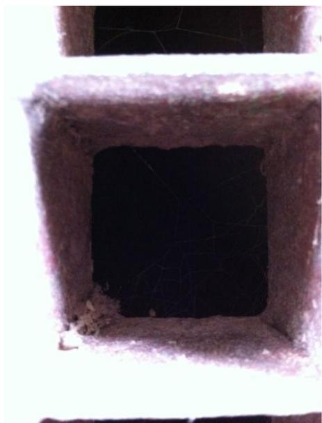
圖 2-9、圓筒倉上方開口之防跌鐵柵蓋附滿玉米碎屑易吸取空氣中水
