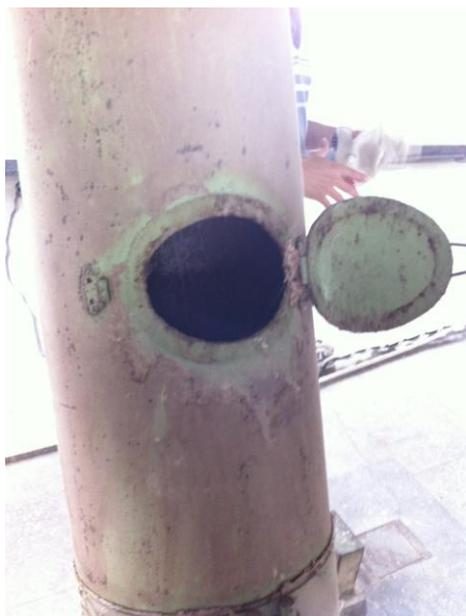
圖 2-23、輸送玉米之管線開口。
