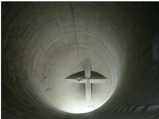
圖 2-11、圓筒倉筒壁與底部所附著或積存玉米碎屑易吸取空氣中水份而致發霉：圖中十字形物為倉底中心運卸系統的保護蓋。
