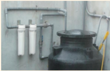
圖13 安裝濾水器改善水質
