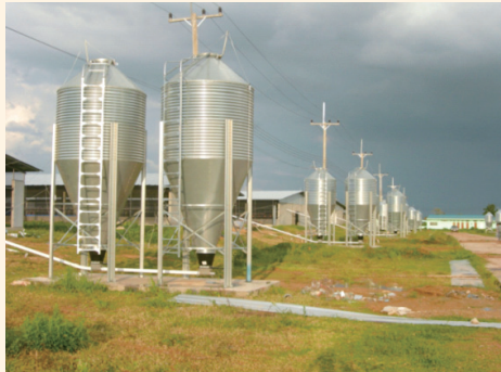
圖16 每棟雞舍設置二個飼料儲存桶
