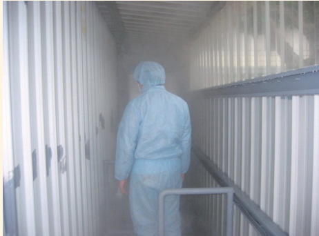
圖3 人員噴霧消毒通道。
