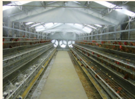
圖24 屋頂使用透光但隔熱的透明板
