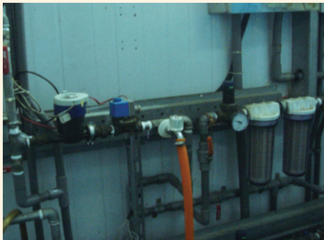
圖9 安裝水表紀錄給水量
