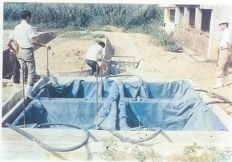
圖 5-3-9 複式厭氣醱酵槽——上覆橡皮覆蓋
