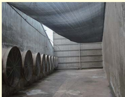
圖 15. 密閉式雞舍抽風機出風口約 4~5 公尺處，架設擋板及除塵網過濾粉塵
