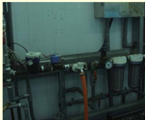
圖 20. 安裝水表紀錄給水量
