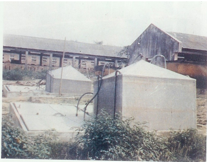
圖 5-3-10 複式厭氣醱酵槽——上覆玻璃纖維覆蓋
