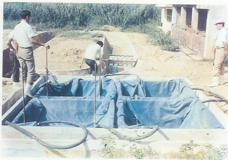
圖 5-3-9 複式厭氣醱酵槽——上覆橡皮覆蓋
