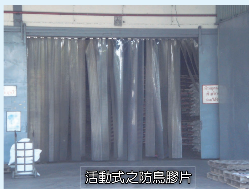
圖5.6 倉儲區設置防鳥設施
